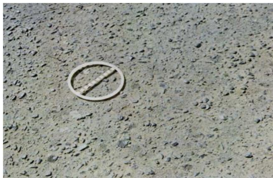
Figura 11. Desgaste
