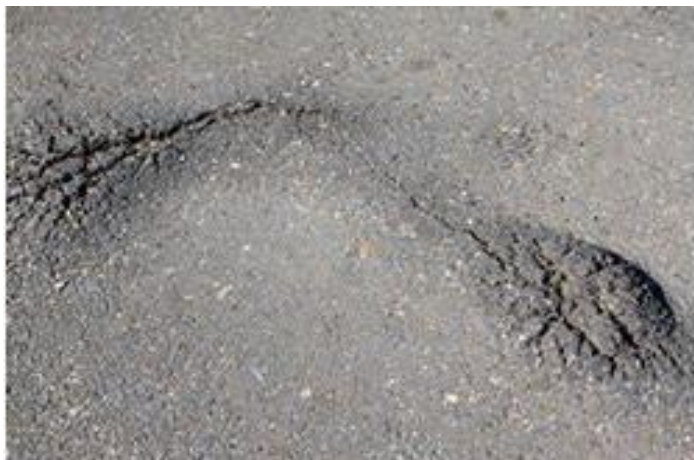
Figura 8. Afundamento Plástico
