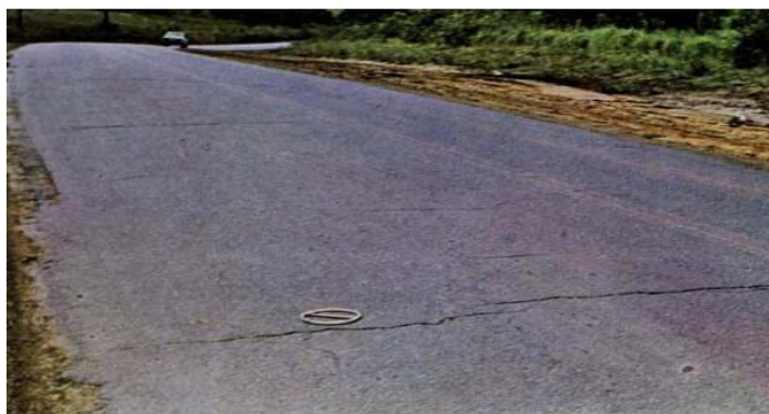
Figura 3. Trinca transversal
