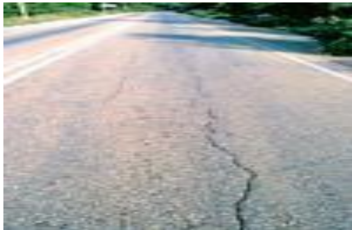
Figura 4. Trinca longitudinal
