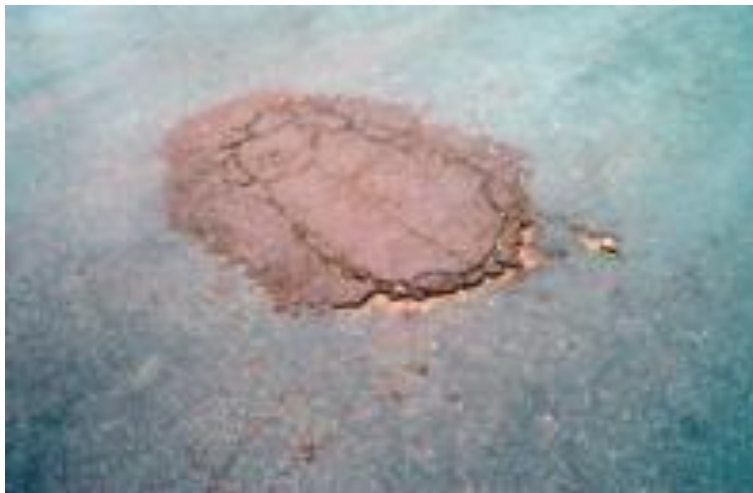
Figura 14. Remendo
