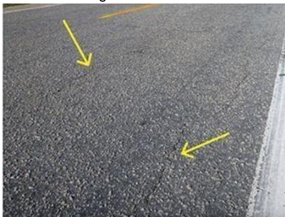
Figura 2. Fissuras
