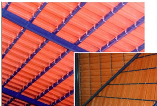
Figura 9: Estruturas do Telhado com Telhas PET
