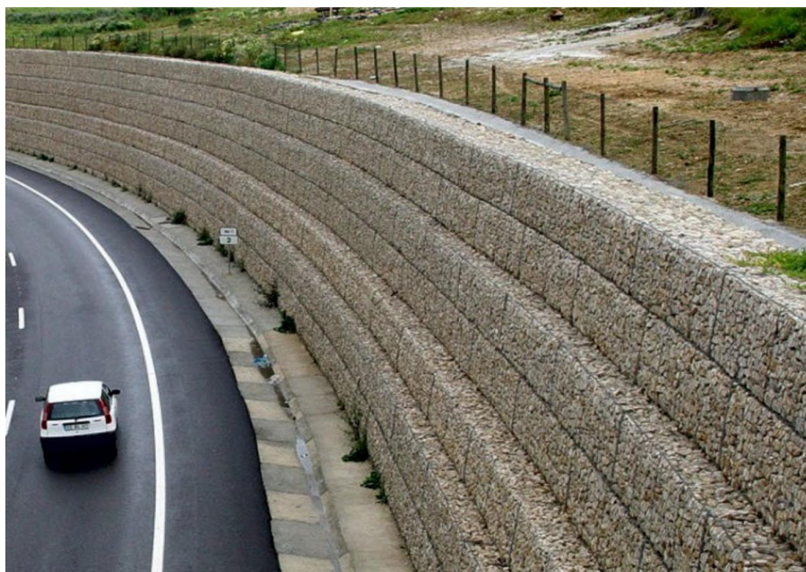
Figura 9. Muro de Arrimo em uma área de estrada.
