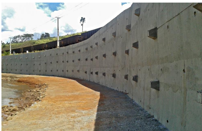
Figura 4: Muro de Cortinas Atirantadas
