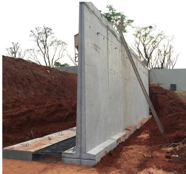
Figura 2. Muro de Concreto Armado
