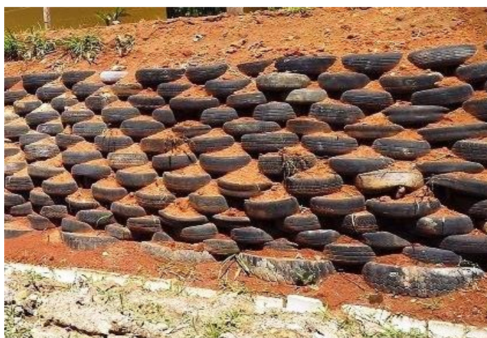
Figura 5. Muro de contenção feito com pneus reutilizados.
