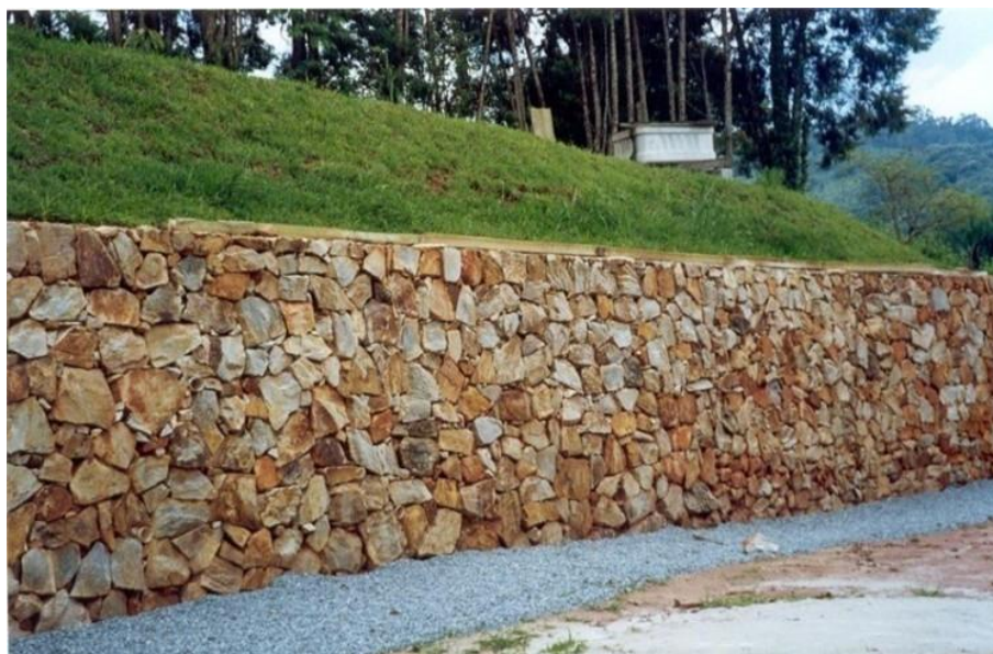
Figura 6. Muro de Pedra Seca
