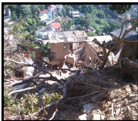
Figura 1 – (a) Escorregamento na Comunidade Cerro Corá, Rio de Janeiro/RJ - 2010.
