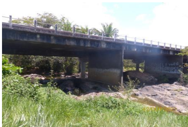
Figura 9. Vista Geral da Obra – Ponte sobre o Rio Real
