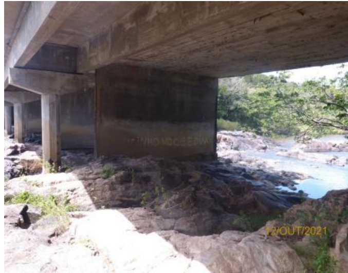
Figura 10. Vista inferior da Obra – Ponte sobre o Rio Real
