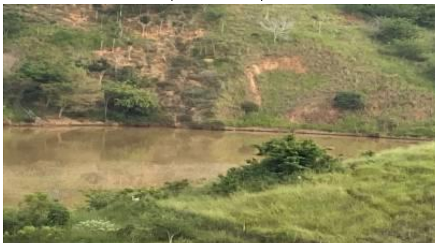
Figura 7. Cinco anos depois da construção da contenção da feição erosiva utilizando técnicas da Bioengenharia – Foto atual do local (abril de 2022).
