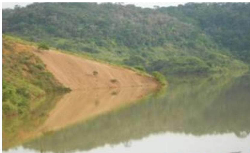
Figura 6. Vista geral da conclusão da recuperação da feição erosiva.
