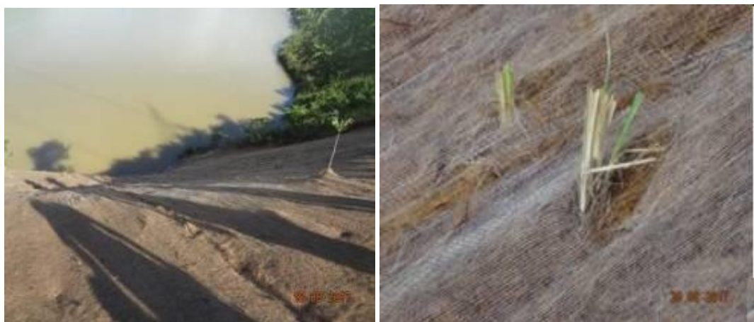
Figuras 5A (esquerda) e 5B (direita). Aplicação de telas vegetais e de mudas de capim Vetiver.
