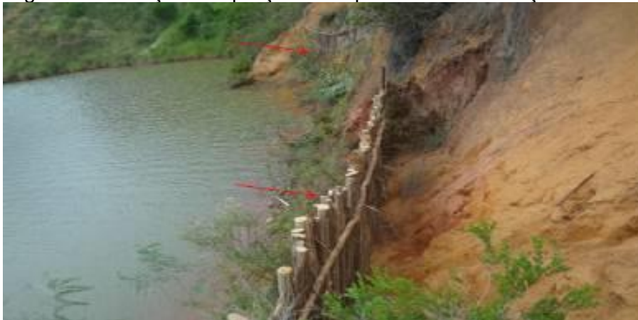
Figura 3. Execução das paliçadas na parte inferior da feição erosiva.
