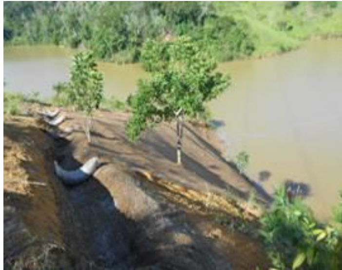
Figura 4. Aplicação da biomanta da canaleta de crista.
