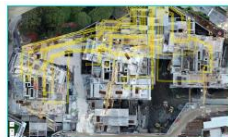
Sobreposições de projetos para liberação de frentes de trabalho
