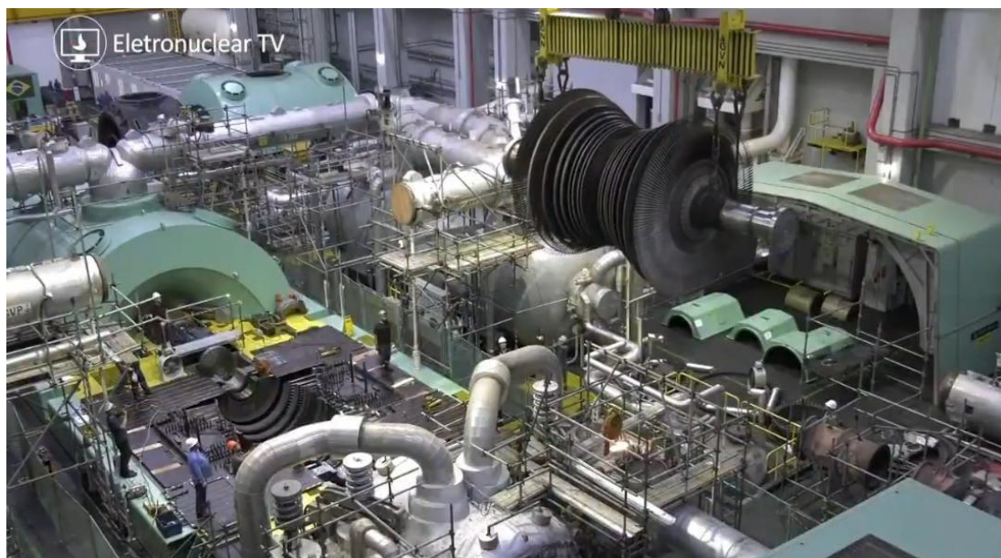
Figura 2: Parada para manutenção de Angra 2 – Edifício da Turbina - UMA
