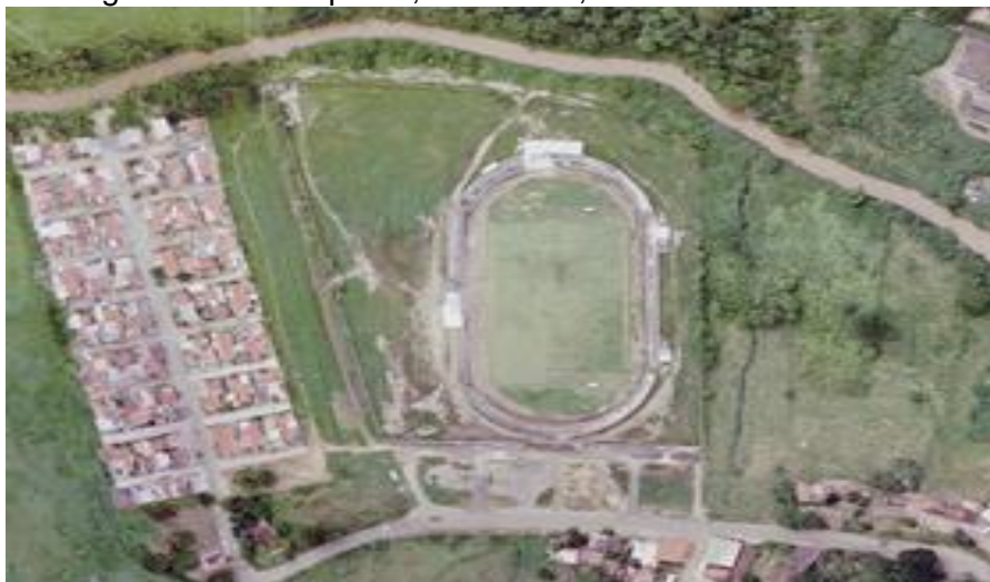
Figura 1. Vista superior, de satélite, do estádio Leão do Sul
