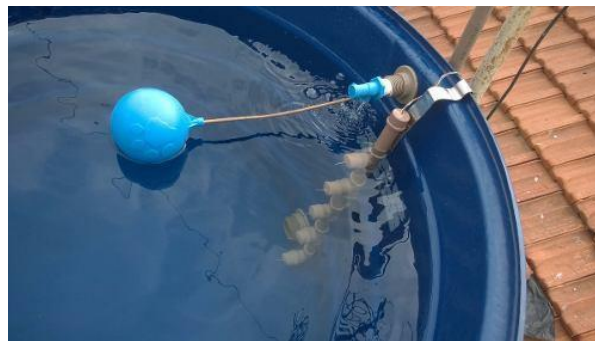
Figura 16. Sensores instalados no reservatório
