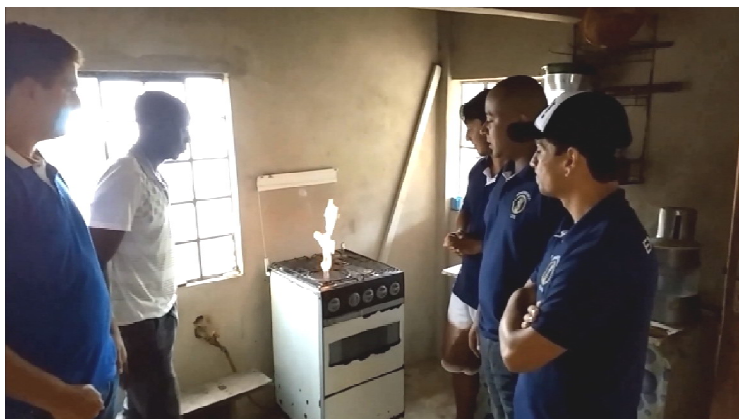
Figura 5: Isaias Bernardo Leite explicando o processo final da tubulação que leva o gás até as casas e a sua eficácia.
