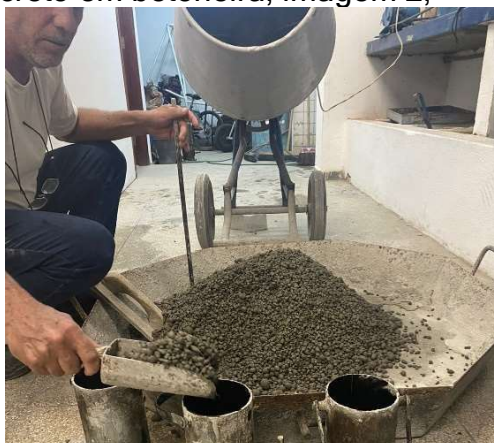
Imagem 2: Preparação do concreto em betoneira Fonte: Autores, 2023
